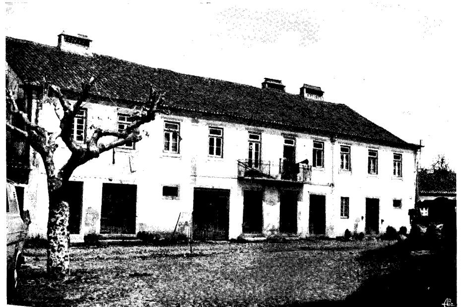
EST. V, B -- Tipo de construção no Rossio de Abrantes. Note-se a ocupação por armazéns nos pisos inferiores.
