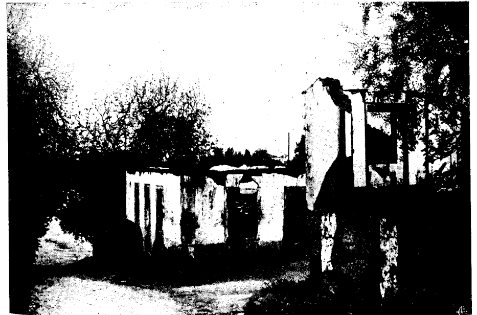
EST. VI, B — Barreiras do Tejo: ruínas de construções junto ao antigo cais.
