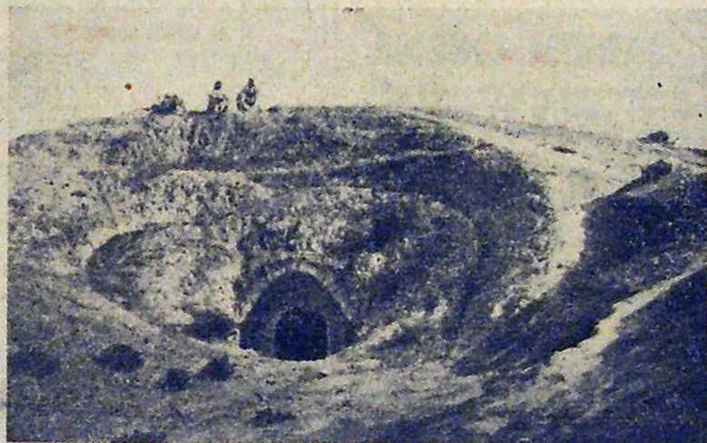
Uma entrada para as obras subterrâneas da Linha de Mareth, no sul da Tunísia
