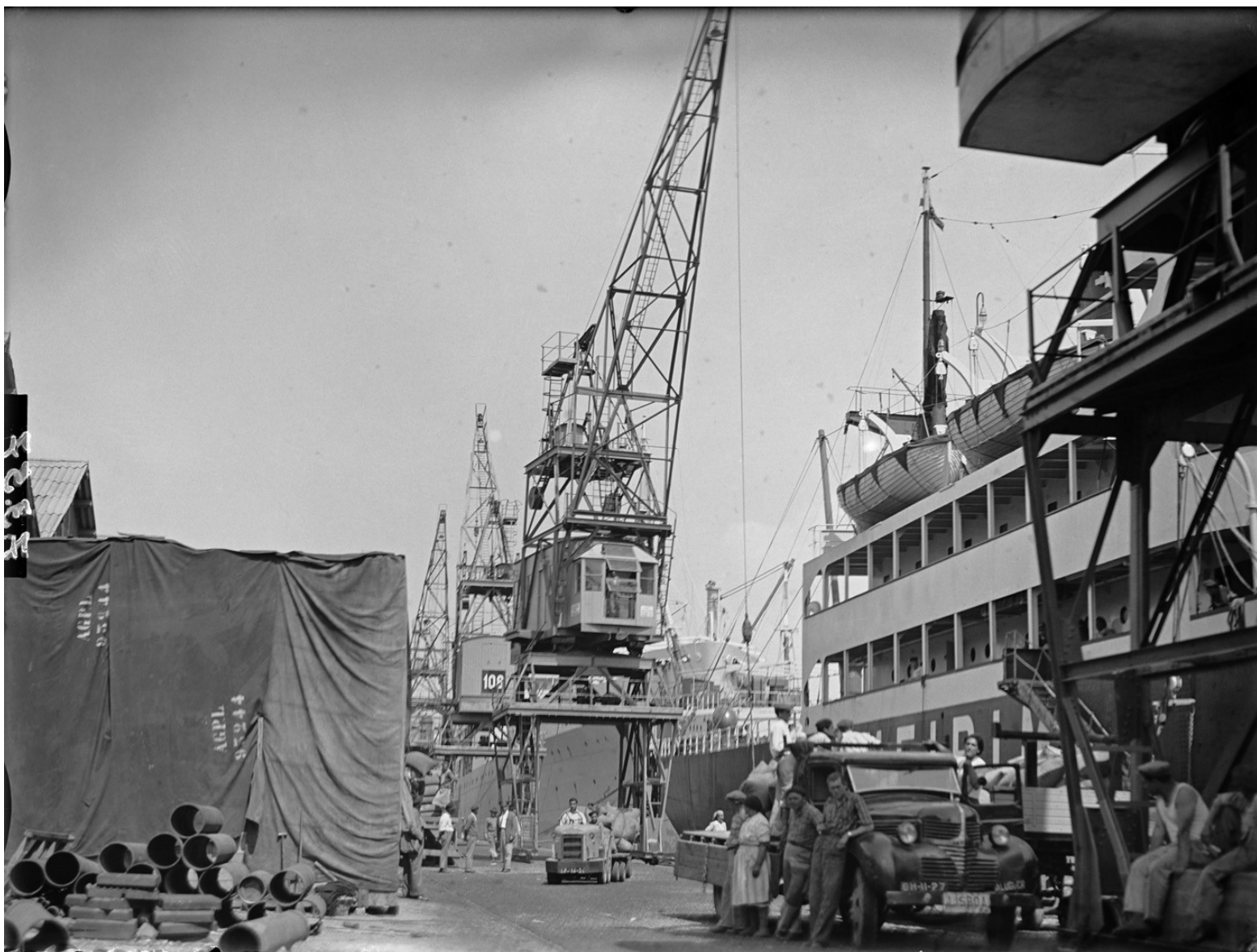
Guindaste "Tramagal" no cais de Alcântara
