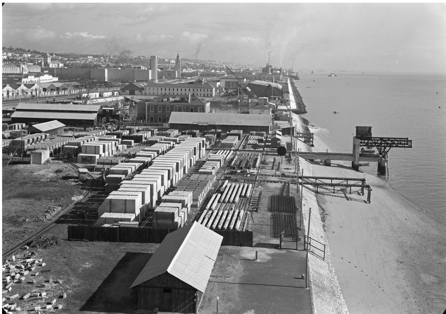
Estaleiro das obras da Doca de Pedrouços
