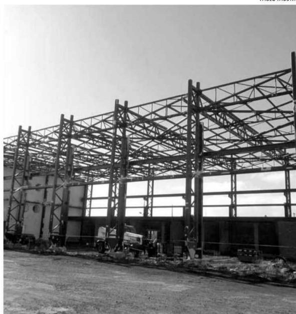
Estrutura a finalizar estará vocacionada para a manutenção de equipamentos
