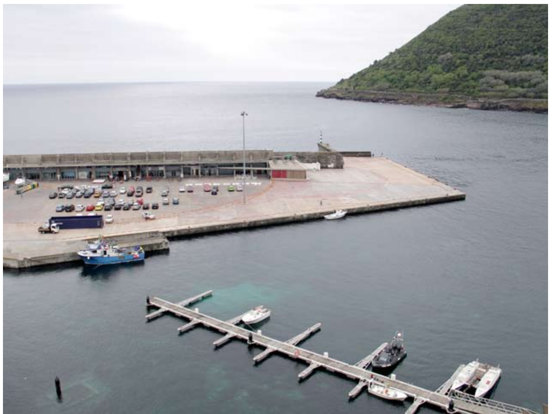
PORTO DAS PIPAS Obras na infraestrutura preveem melhorias de operacionalidade e segurança
